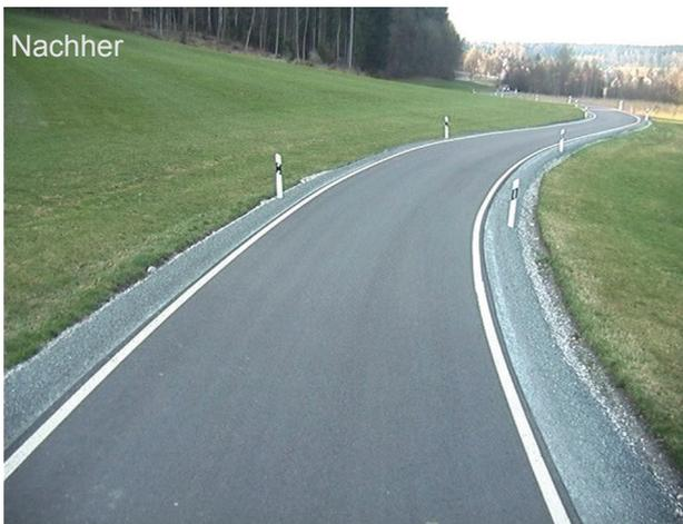
Unebenheiten und Risse in der Fahrbahndecke stellen insbesondere für Motorradfahrer ein Sicherheitsrisiko dar. Durch die Beseitigung dieser Schäden soll die Gefahr von Stürzen verringert werden.
