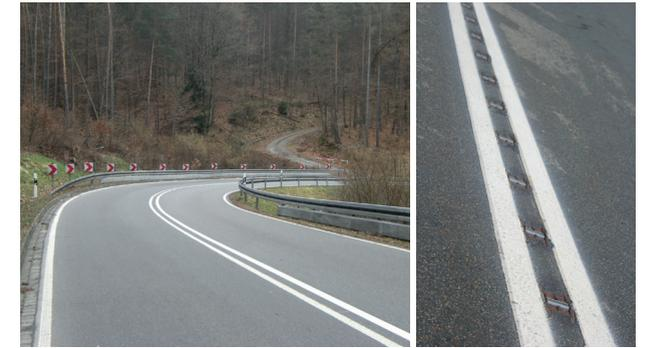
Eine markierte Doppellinie soll das Überholverbot auf kurvigen Strecken verdeutlichen. Gleichzeitig soll diese Motorradfahrer in Innenkurven davon abhalten, sich zu weit in den Gegenfahrstreifen zu neigen. Eingebaute Reflektoren erhöhen zusätzlich die Erkennbarkeit des Kurvenverlaufs.
