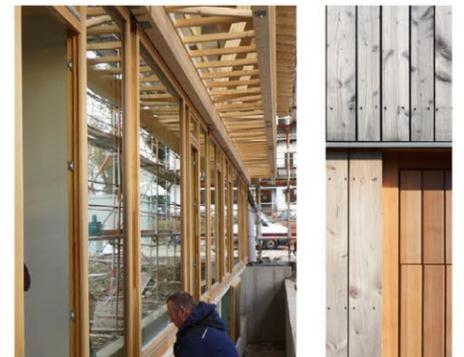
Für Wand, Decke, Dach und Fassaden wurde als Baustoff Holz verwendet mit naturbelassener Lärchenholzschalung
