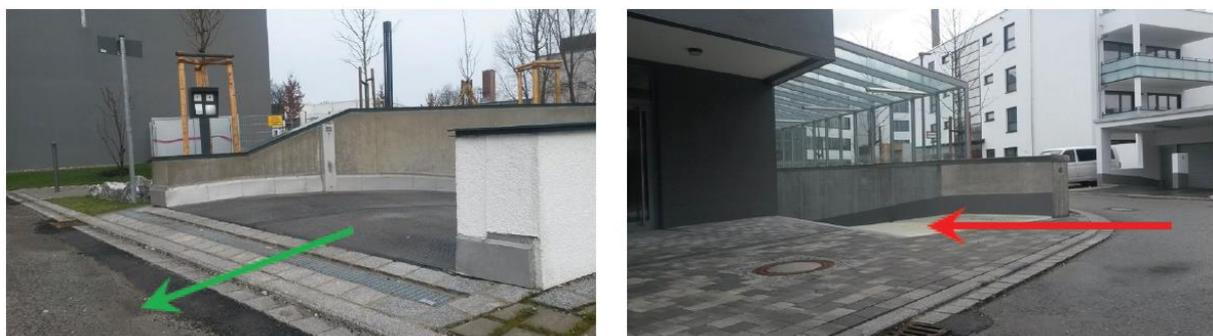
**Abbildung:** Mit einfachen Mitteln lassen sich im Rahmen der Bauvorsorge Risiken wirkungsvoll reduzieren. Beispielsweise kann bei Tiefgarageneinfahrten mit einer Schwelle weitgehend verhindert werden, dass Oberflächenwasser von der Straße aus eindringen kann (links). Im anderen Fall besteht die Gefahr, dass schon bei geringen Wasserständen auf der Straße Wasser in die Tiefgarage läuft (rechts). (Fotos: P. Geisenhofer – WWA Rosenheim)
