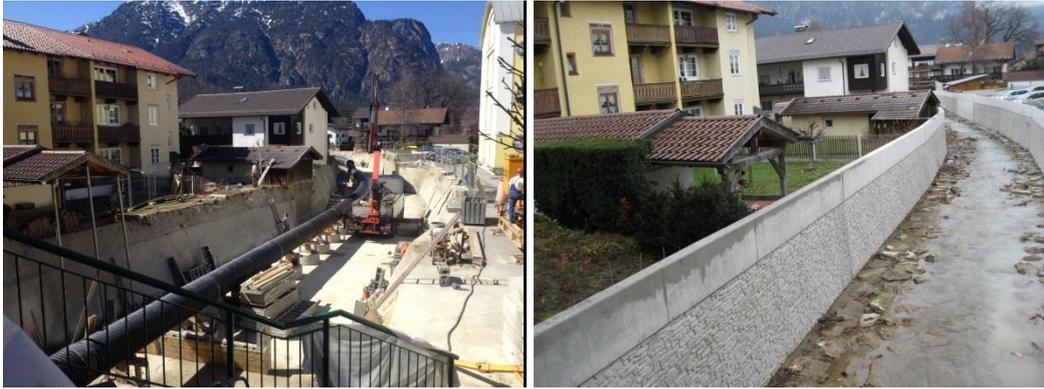
**Abbildung:** Hochwasserschutz – Baustelle (links) und abgeschlossene Maßnahme (rechts): Die gewässernahe Bebauung ließ die Kosten explodieren. Nur mit extrem aufwendigen Sonderverfahren und Beweissicherungsprogrammen war überhaupt eine Lösung zu finden. Doch die Probleme sind mit dem Bau nicht vorbei, spätestens bei der turnusmäßig durchzuführenden Unterhaltung tauchen sie wieder auf. Ebenso ist im Hochwasserfall eine Zugänglichkeit für Einsatzkräfte nicht gegeben.
