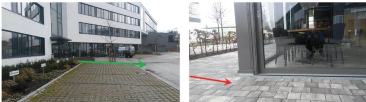
**Abbildung:** Das umliegende Gelände sollte so gestaltet werden, dass Niederschlagswasser vom Gebäude wegfließen kann (links). Ein Gebäude, dessen Erdgeschoss unter dem Straßenniveau liegt, ist bei Starkregen besonders gefährdet. (Fotos: P. Geisenhofer – WWA Rosenheim)
